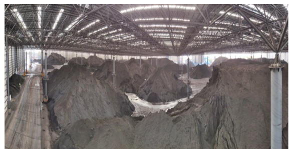
图 5 大跨钢结构现场
